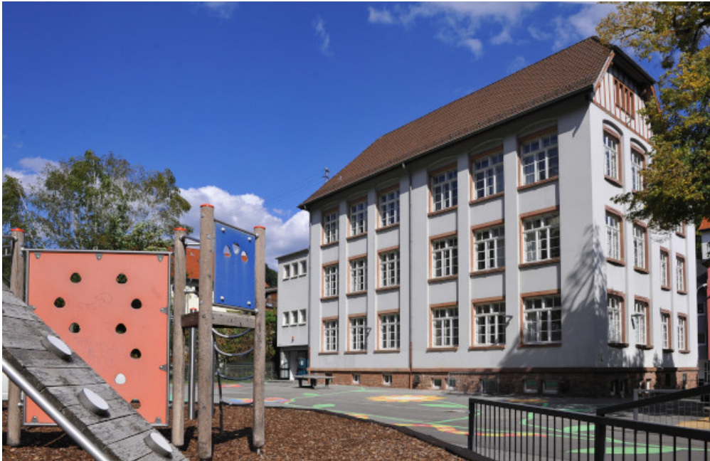
Abb. 80: Ansicht der Grundschule Ziegelhausen (Neckarschule)
