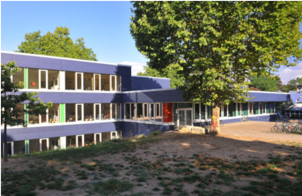
Abb. 64: Ansicht der Primarstufe der Internationalen Gesamtschule Heidelberg
