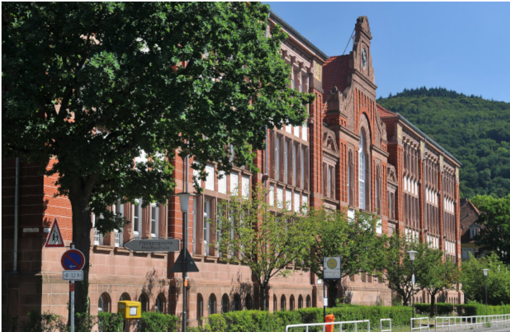
Abb. 119: Ansicht der Johannes-Kepler-Realschule
