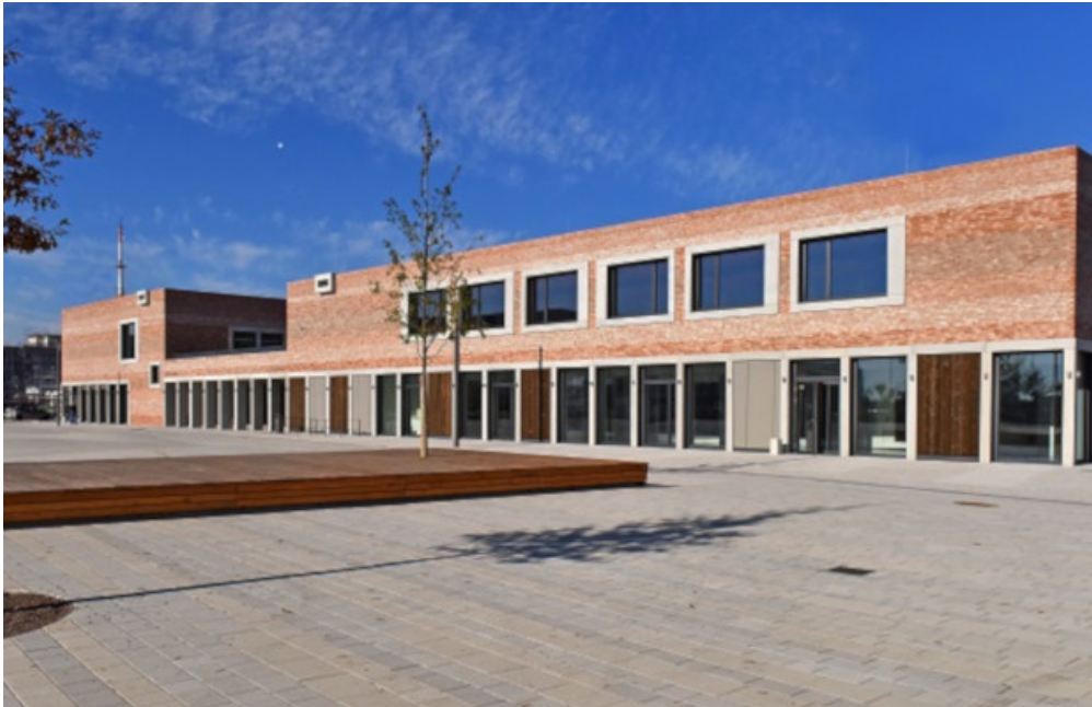
Abb. 84: Ansicht der Grundschule Bahnstadt
