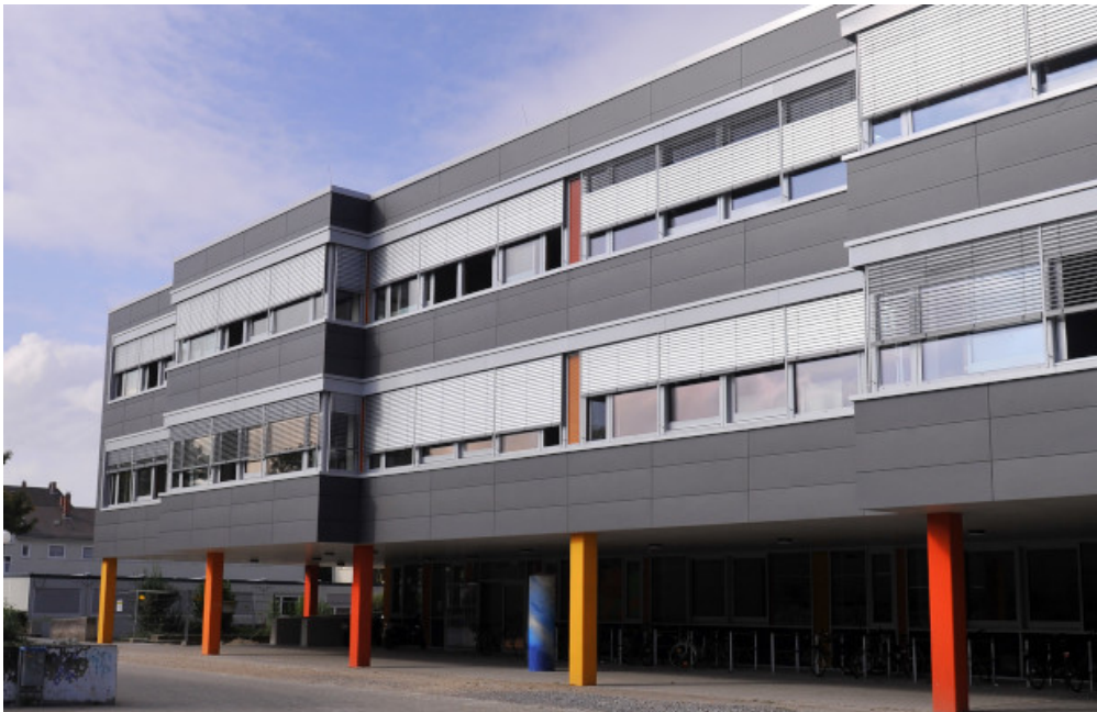
Abb. 114: Ansicht der Internationalen Gesamtschule Heidelberg
