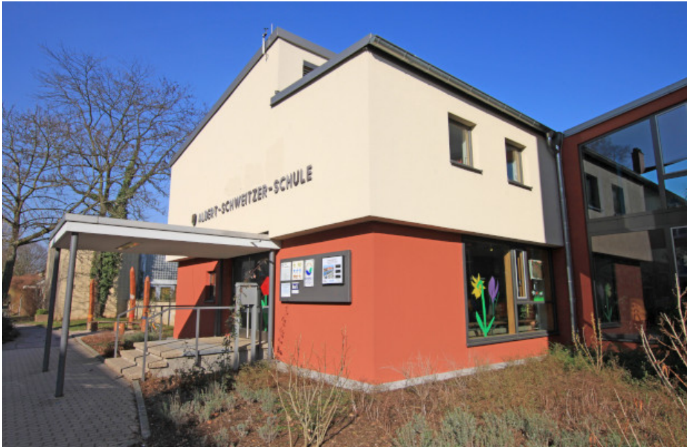
Abb. 44: Ansicht der Albert-Schweitzer-Schule
