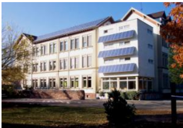
Abb. 103: Schulgebäude der Kurpfalzschule
