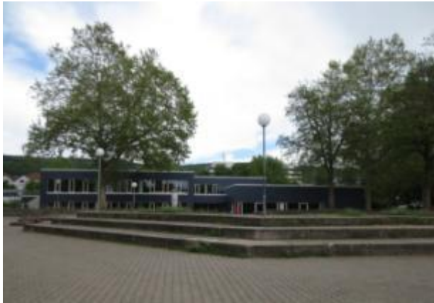
Abb. 89: Schulgebäude der Primarstufe der Internationalen Gesamtschule
