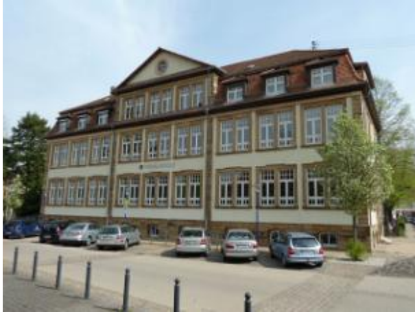
Abb. 61: Schulgebäude der Fröbelschule
