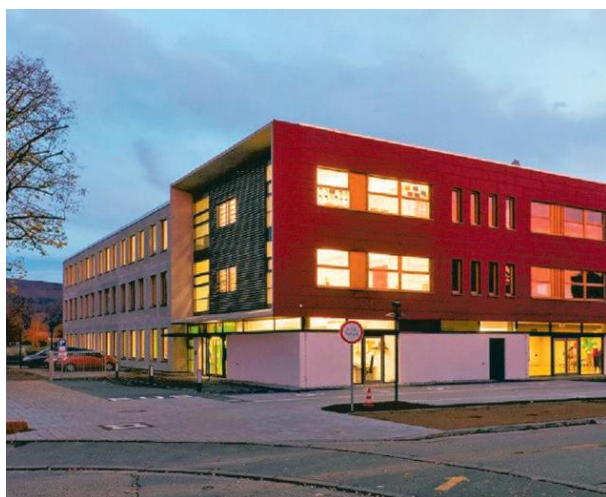
Abb. 226: Schulgebäude Heidelberg International School (H.I.S.)
