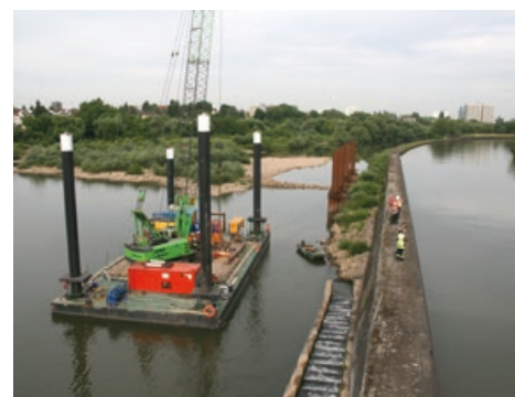
Unten Die Arbeitsplattform unterhalb des Wehrstegs.
