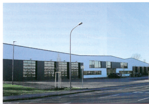
Das in 2015 bezogene Feuerwehrhaus Wieblingen wird gemeinsam mit der DLRG Heidelberg genutzt
