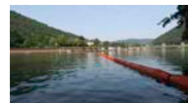
Fertig ausgebrachte Ölsperre an der Schleuse Neckargemünd
