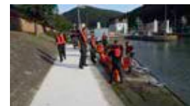
Die Ölsperrensegmente werden zusammengesetzt
