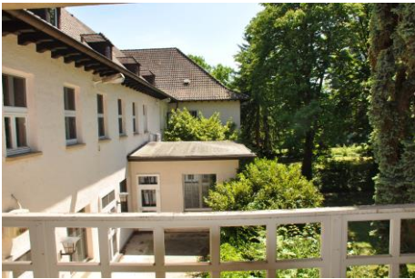
Bild 1: Blick auf den Flachbau
