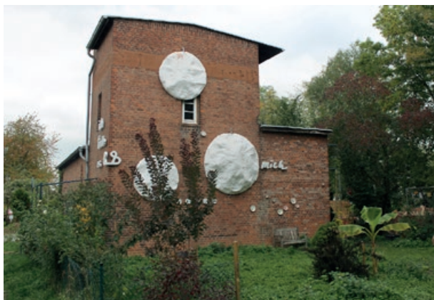
Haus am Wehrsteg mit Skulpturen © Matthis Bacht
