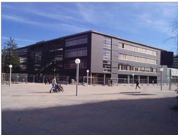
1. Bauabschnitt – Physikalisches Institut
