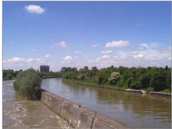
Neckarkanal am Wehrsteg
