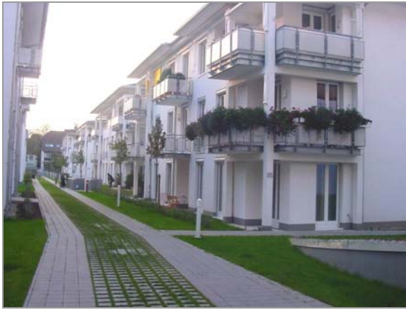
Neubebauung in den Winter'schen Höfen - Lutherstraße
