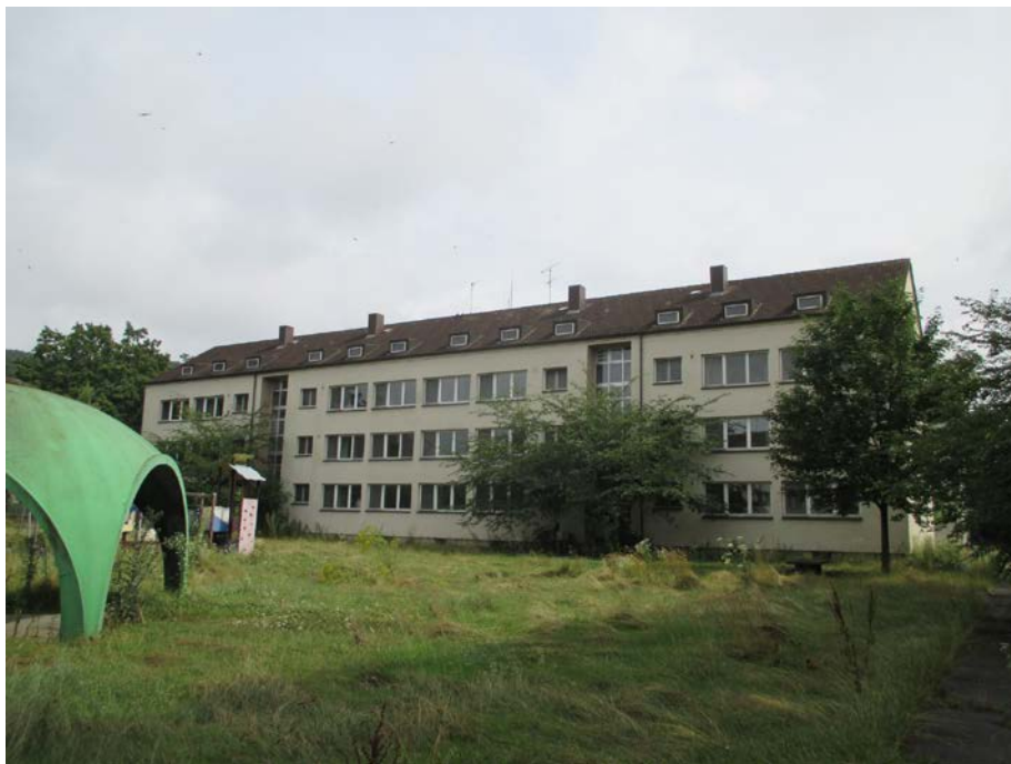
Foto 1: Gebäude 3703 (Ansicht von Norden)
