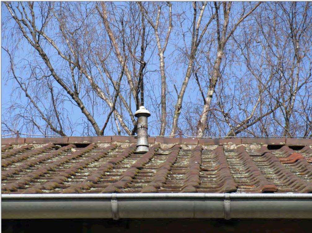
Abbildung 11: Spalten im Bereich der Firstziegel (Werkstattgebäude)
