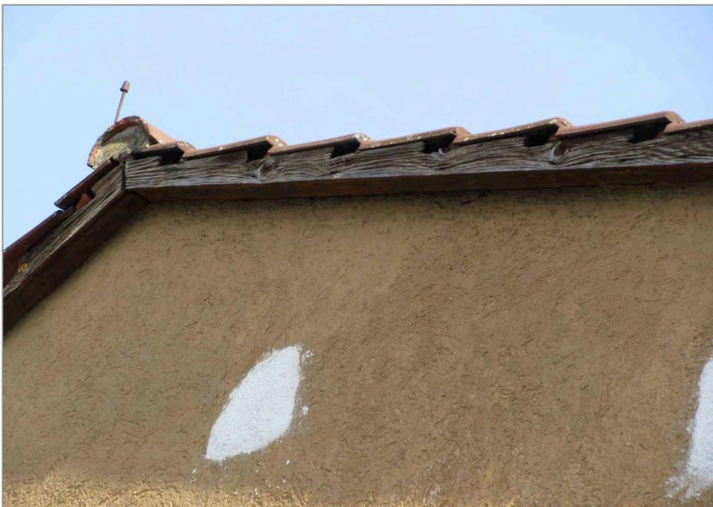
Abbildung 13: Spalten im Bereich des Ortgangs (Werkstattgebäude)
