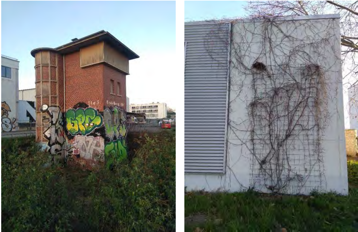
Abbildung 3: links: Stellwerk mit Haussperlings- und Nischenbrüterkästen; rechts: altes Nest an der Eppelheimer Str. 36
