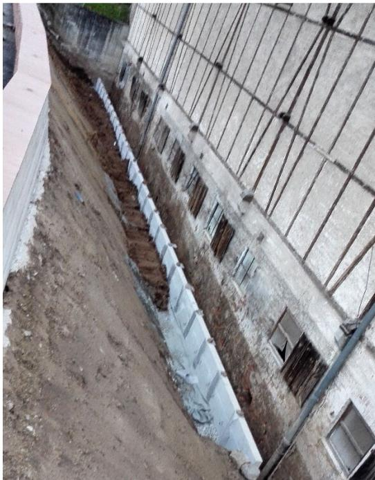
Abbildung 4: Herstellen der Bohrpfahlwand 2016 (links) und der Drainage 2017 (rechts)
