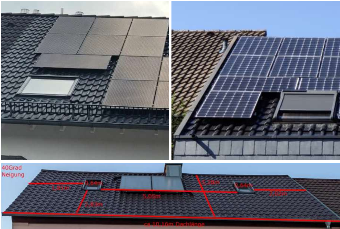
Oben links: Hoch- und Quermontage kann kombiniert werden. Oben rechts: Eine Belegung bis kurz an den Dachrand, First oder Traufe ist fast immer möglich. Unten: Ideale Vorarbeit für den Solarteur: Eine genaue Dachbemaßung. (Fotoquelle: Photovoltaikforum.de)
