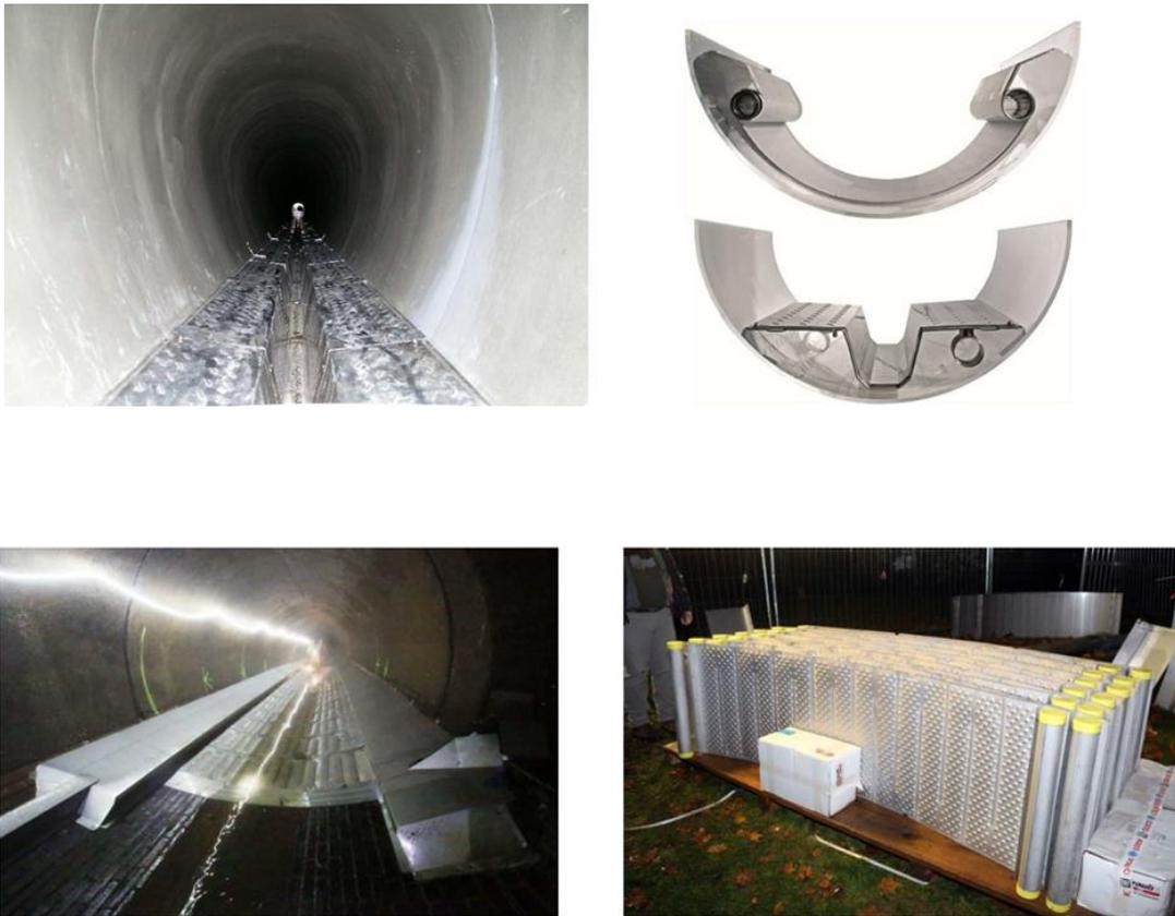
**Abbildung 57: Abwasserwärmetauscher (Bildquelle: Fa. Uhrig (oben), Stadtwerke Aachen (unten))**
